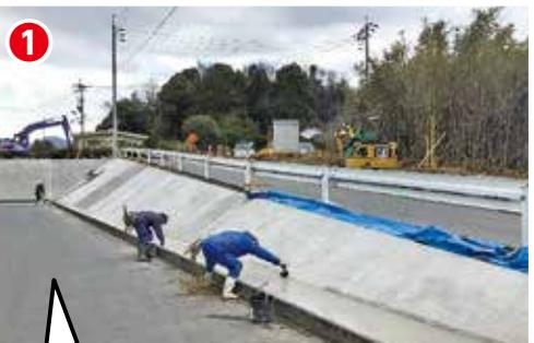
豪雨時の雨水対策として、排水溝の改修や法面を補強しています。
