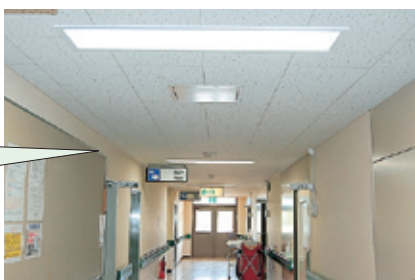
2F 本館棟廊下
