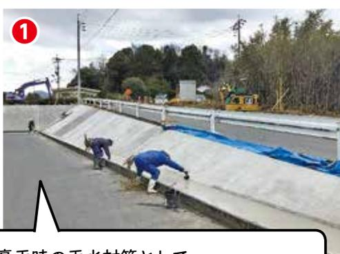
豪雨時の雨水対策として、排水溝の改修や法面を補強しています。
